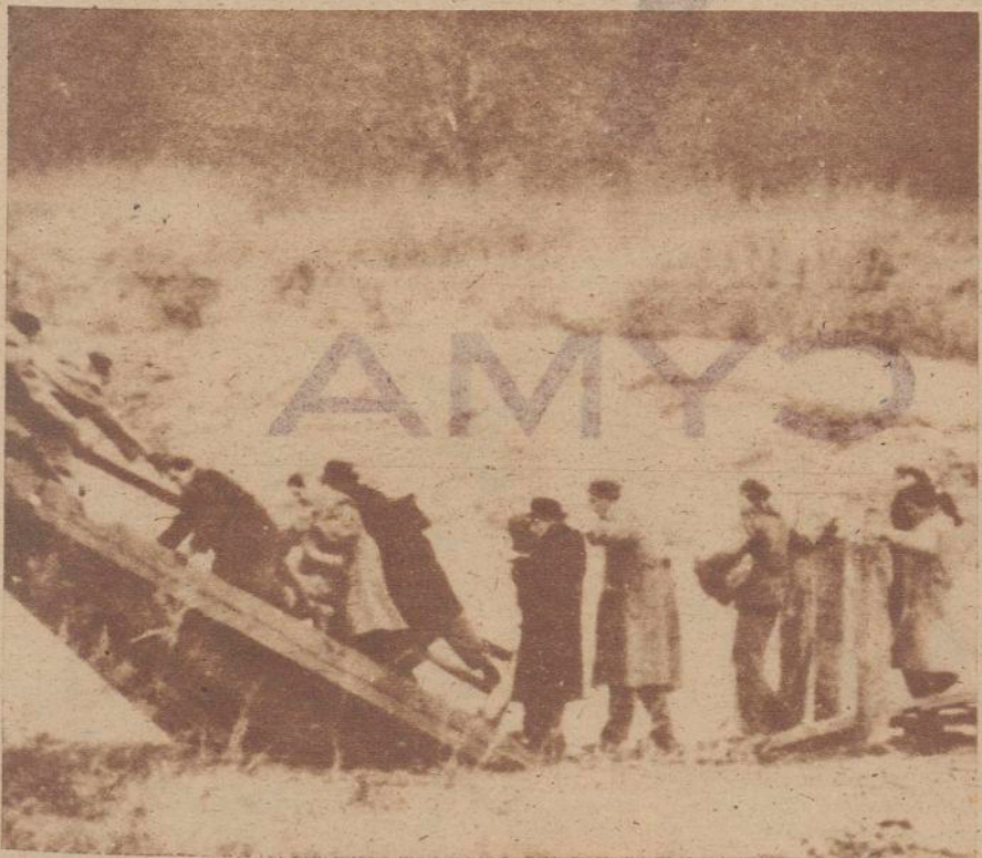
A PESAR DE LOS PUENTES HUNDIDOS. —Un grupo de refugiados húngaros atraviesa un puente hundido sobre un canal cerca de la frontera austrohúngara. Es uno de los muchos puentes hundidos por los soviéticos para evitar el éxodo de los patriotas.—Foto Cifra.
