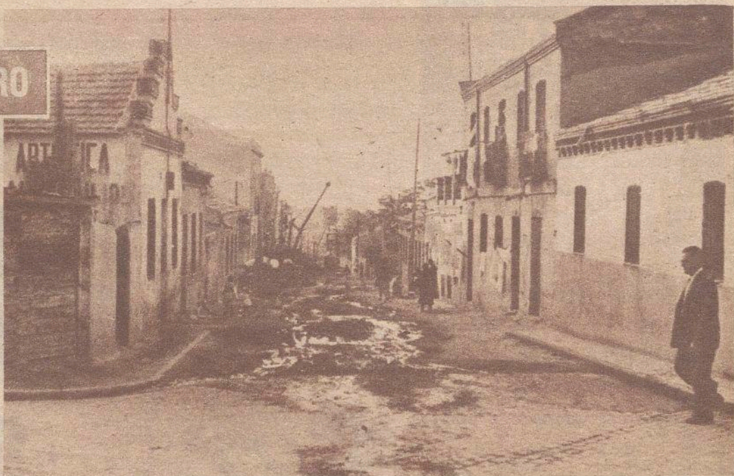
Calle de la Veza, donde se han iniciado las obras de excavación correspondientes al colector del llamado Arroyo del Francés.
