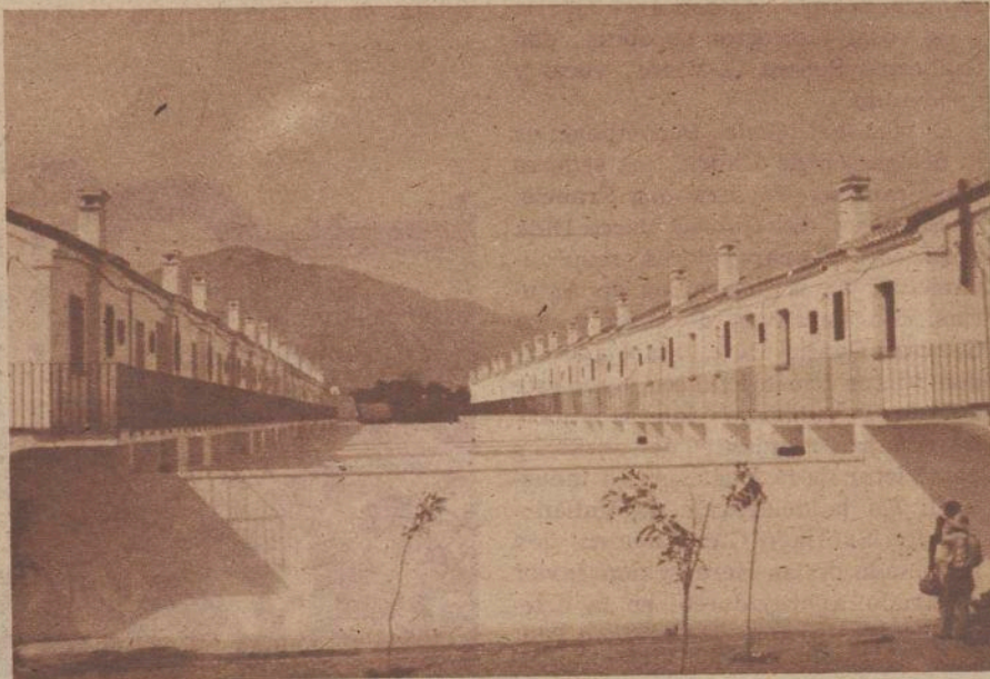
Uno de los grupos de viviendas para pescadores (122 viviendas) construidos en Fuengirola (Málaga).
