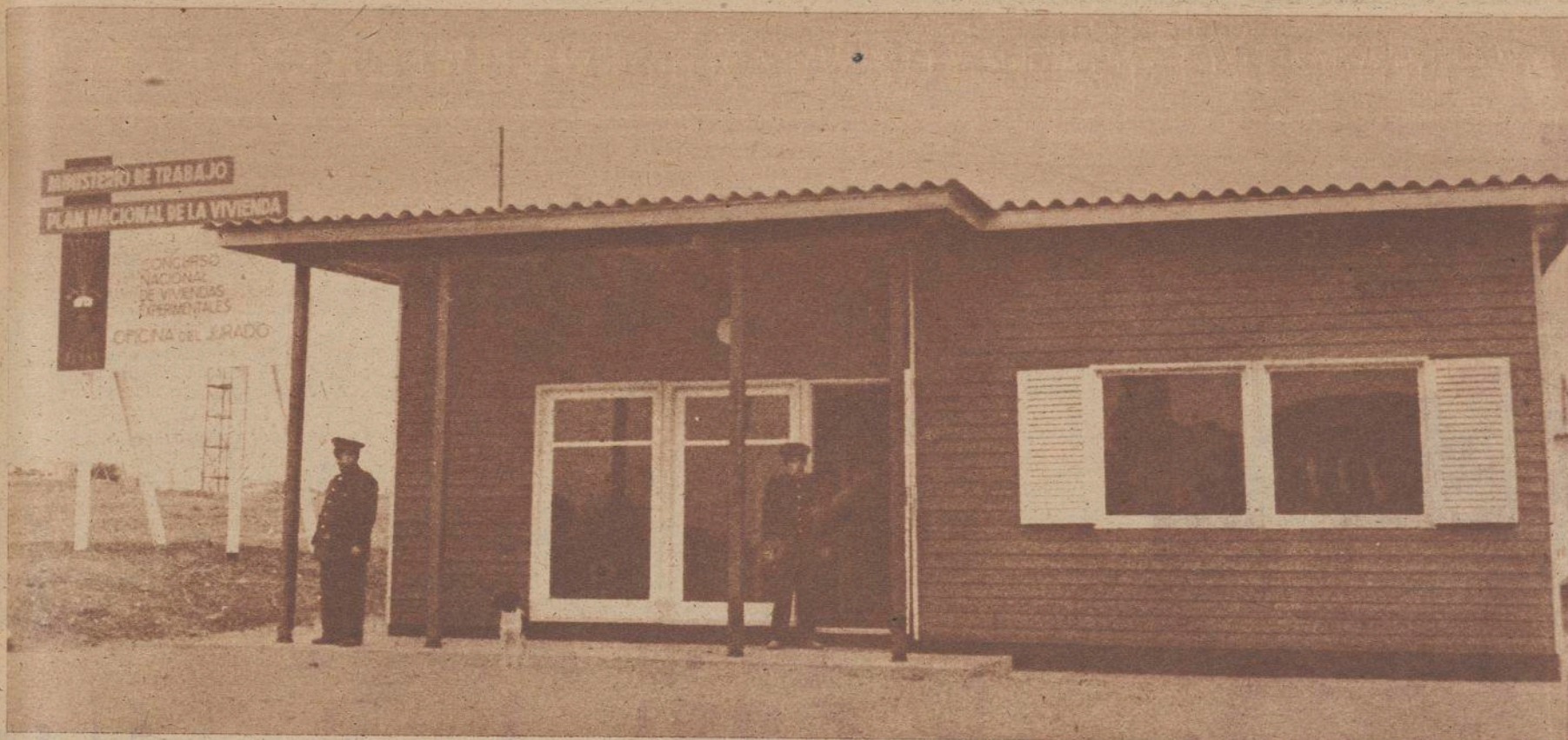
Oficinas del Instituto Nacional de la Vivienda en los terrenos donde se llevan a efecto las obras experimentales.—Foto Torremocha.
