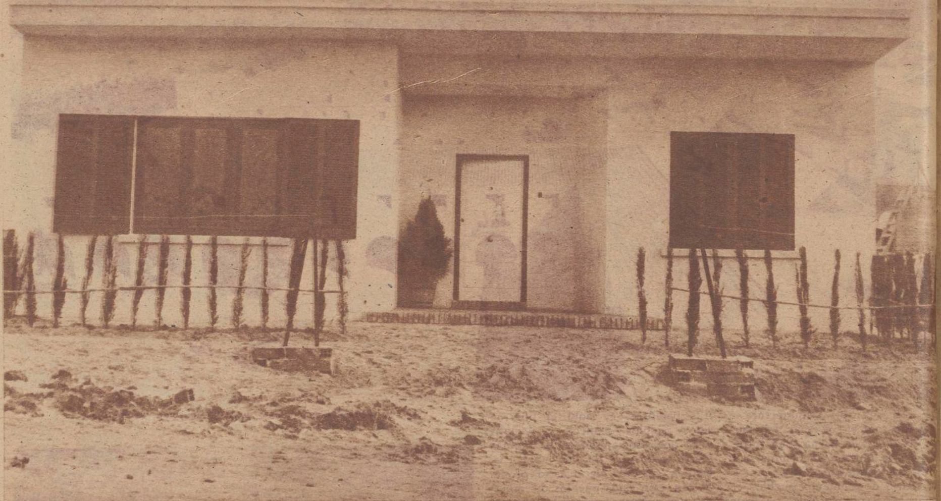
He aquí el aspecto que ofrece, una vez terminada, la vivienda experimental construida por Ytong Hispano Luso, S. A.
