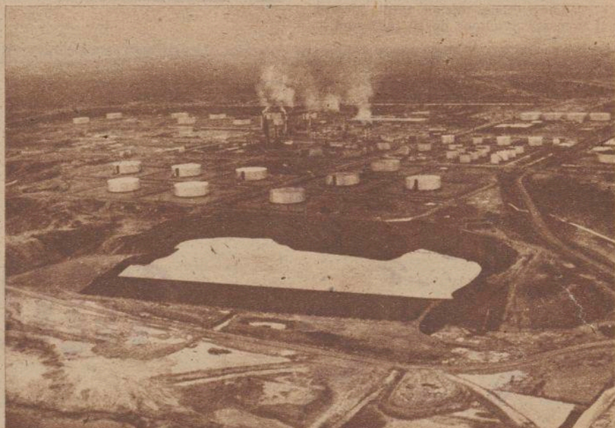
Gran depósito de aceite combustible al aire libre. Al fondo, otros depósitos petrolíferos.
