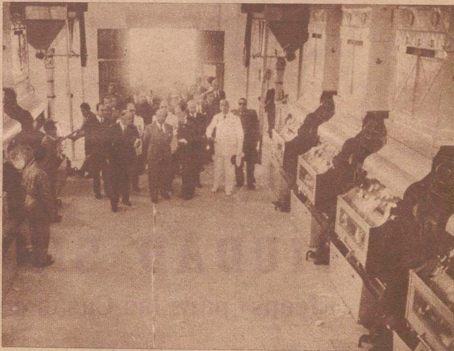
Otros aspectos de la visita del Caudillo a la factoría algodonera de Talavera de la Reina. Sala de desmotación con las instalaciones en pleno rendimiento.
