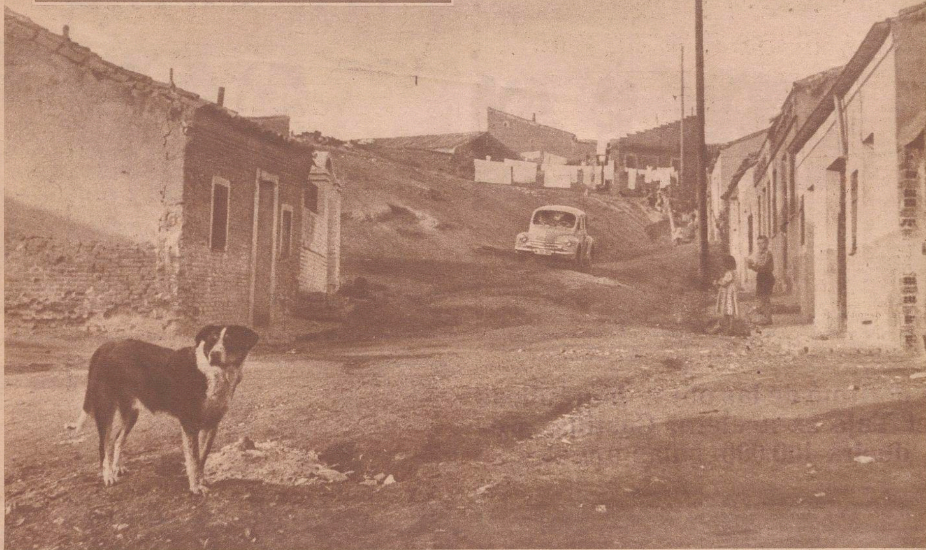
Calle de las Almortas. Adviértase la pericia que ha sido preciso utilizar para salvar el terraplén del fondo. ¿Creen que la hazaña sería factible con barrillo o, lo que es peor, con nieve?
